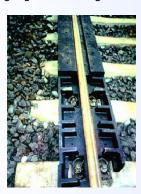
Bei Verwendung der "Spreepolymer-Schienenranrofile" kann auf die instandhaltungsträchtige Beischiene oder auf das Herstellen von Spurrillen im Bitumen völlig verzichtet werden.
